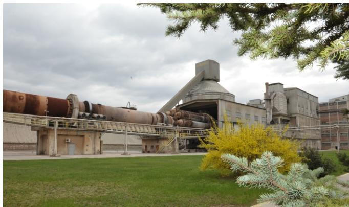
Proizvodnja klinkera zahteva visoke temperature – iznad 1.450°C
