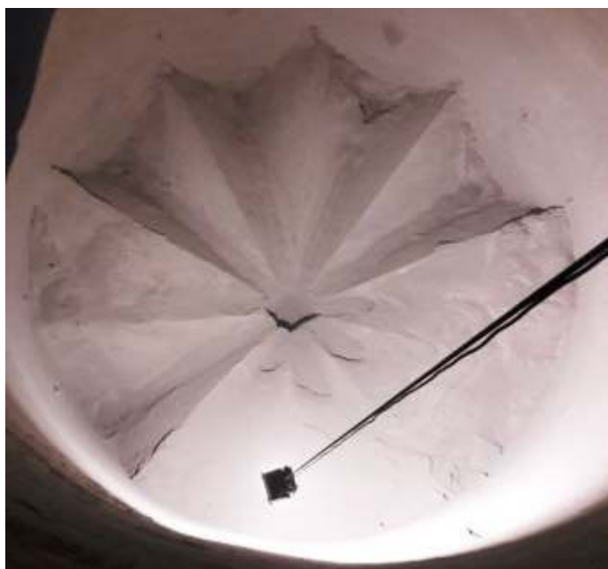
Unutrašnjost silosa cementa
