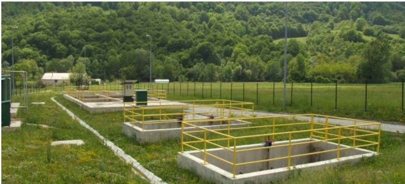
Postrojenje za prečišćavanje otpadnih voda – 2010. godine
