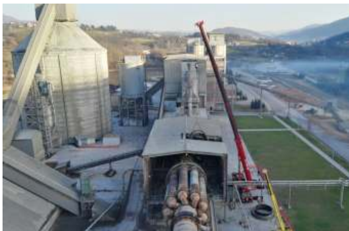
Demontaža starog nosivog prstena
