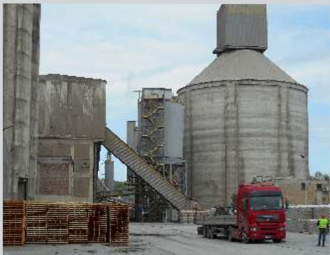
Rekonstruisan silos letećeg pepela na mlinu cementa – 2010. godine
