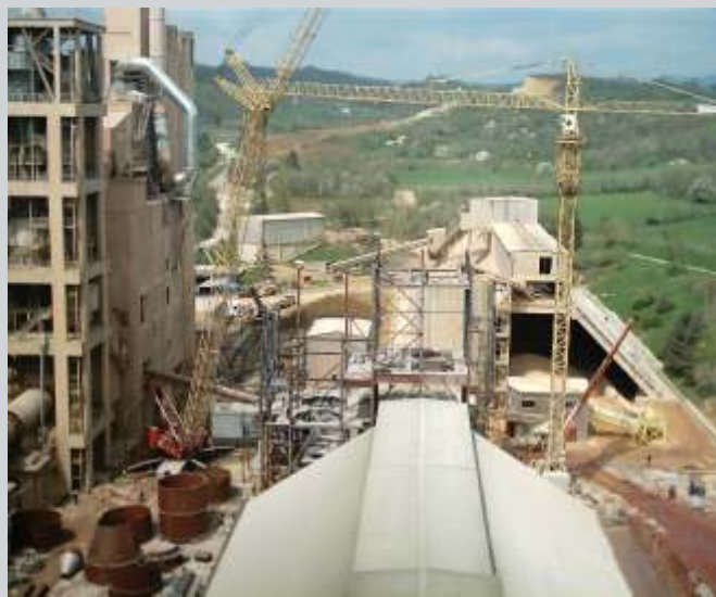
Izgradnja mlina i skladišta za čvrsta goriva – 2004. godine
