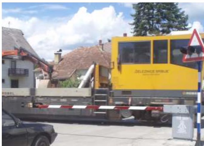
Šta je realizovano ovim projektom? Ugrađen je SIEMENS-ov procesni uređaj najnovije generacije za upravljanje i kontrolu rada putnog prelaza. Postavljene su nove elektropostavne sprave sa polubranicima. Reparirani su kontrolni signali, kućica putnog prelaza, postavljen je novi asfalt preko kolovozne površine. Reparirani su postojeći i ugrađeni novi putoprelazni signali. Obnovljena je postojeća i postavljena dodatna, vertikalna i horizontalna saobraćajna signalizacija,
